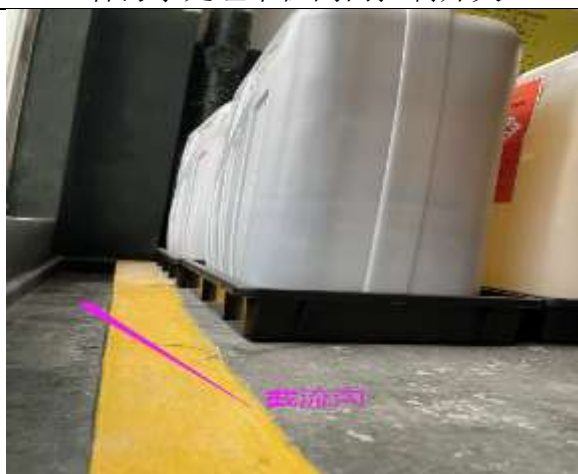
危废间内截流沟
